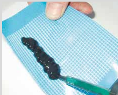
Kanna liim otse tugevduslindile. Jälgi, et segamistoru ots oleks liimiga pidevas kontaktis, et ei tekiks õhumulle.
